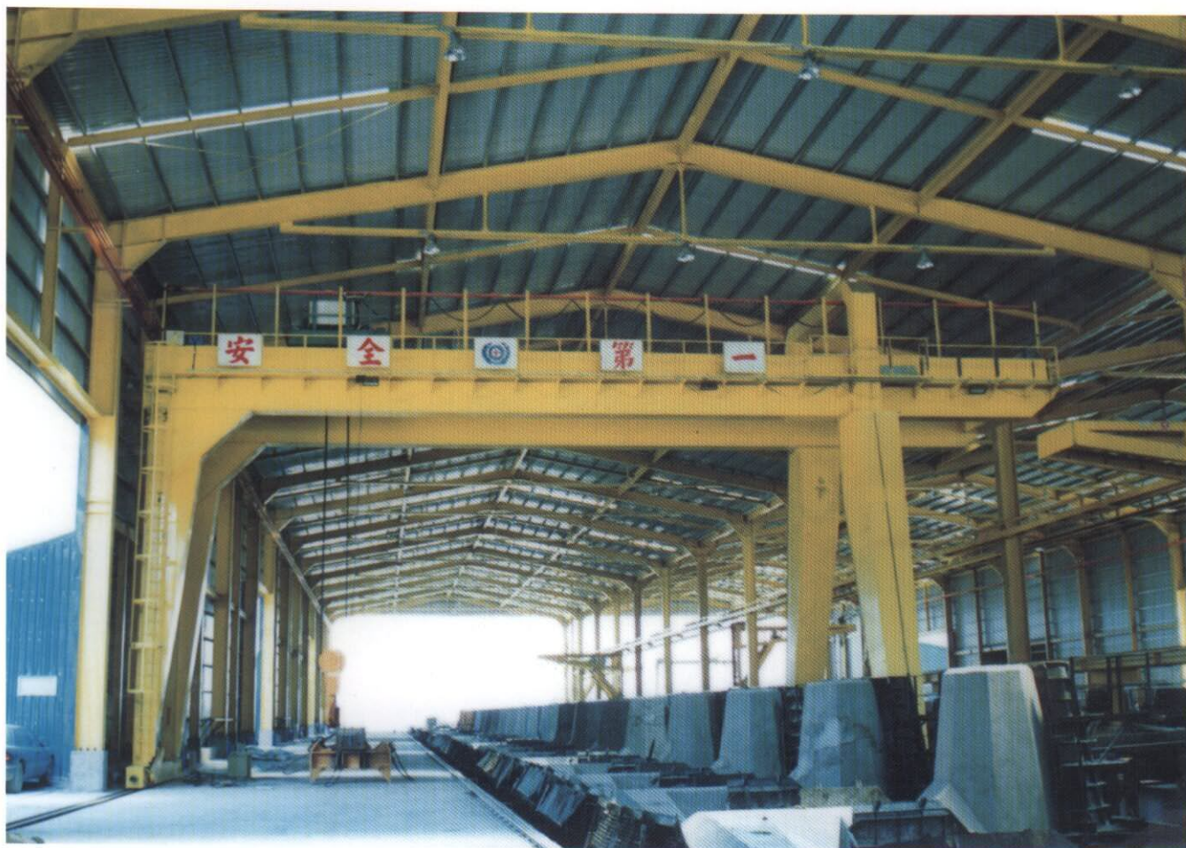
門型起重機 (100t SPAN 25M+5M+5M) 億承工程和平廠實攝
